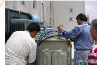
4. 將設備接上高壓一次側電源線
