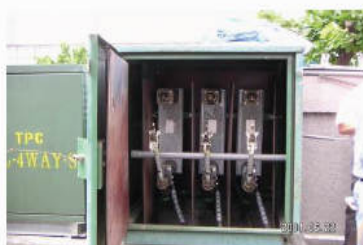
1. 切斷電力公司高壓電源開關
