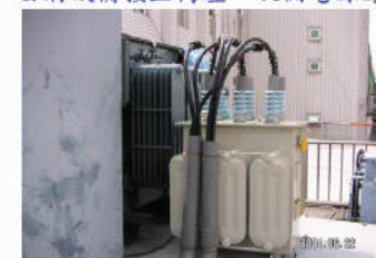
6. 節能設備安裝完畢
