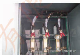
2. 電力高壓端接地以防止意外
